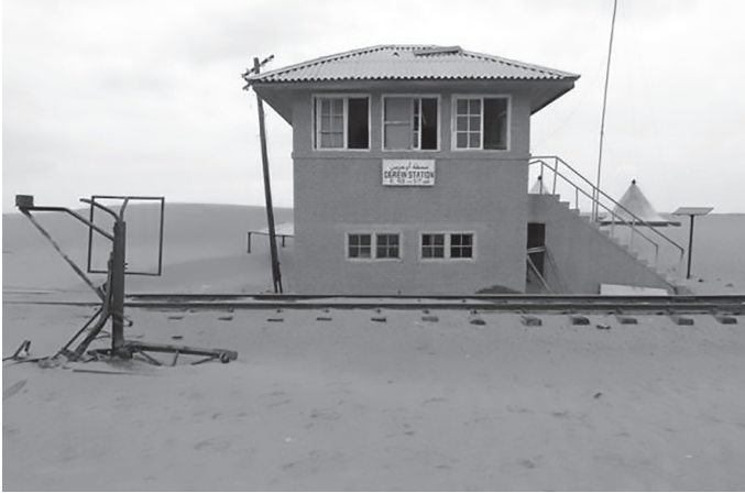
برج السيمافور ومنصة ناظر المحطة لأخذ التابلت من سائق القطار.
